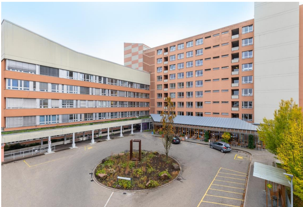
Das neue Bettenhaus befindet sich zwischen dem Südbau und dem Hauptgebäude des Klinikums Ortenau © drapilux
